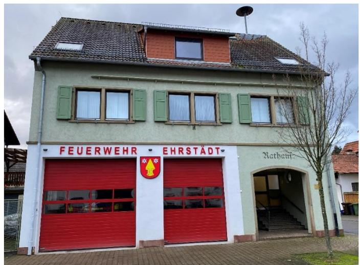
Im Mai 2023 wurde mit den Umbauarbeiten am bestehenden Feuerwehrhaus begonnen. Hierbei stand im Vordergrund, dass die Toreinfahrt mit den bestehenden Torbögen mit den Holztoren und der viel zu geringen Breite angepasst werden musste, so dass die Ersatzbeschaffung, das Löschgruppenfahrzeuges LF20KatS, auch in die Fahrzeughalle einfahren kann.
